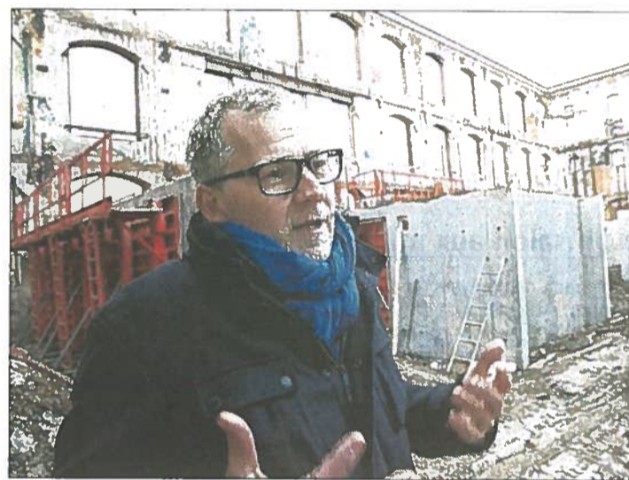
Jean-François Hurth, à l'intérieur du bâtiment, mercredi dernier. Le gros œuvre du rez-de-chaussée est déjà presque achevé.
