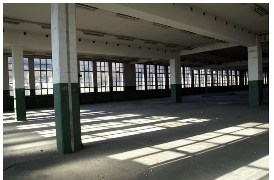
Le Louvre est un des plus anciens bâtiments de la région construit en béton armé. À l'intérieur, une hauteur de plafond de 5 m, des fenêtres et encore des fenêtres...
