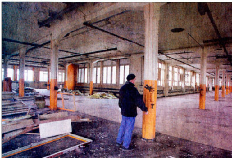
Le premier étage s'étend sur plus de 3000 m 2 autour d'un patio central. Les premiers travaux concernent l'isolation et la viabilisation. Ensuite, chacun pourra aménager son espace.
