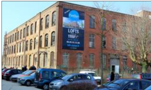
Ce bâtiment de briques, avec une structure intérieure métallique, est une ancienne menuiserie de la SACM. Il date de 1886.
