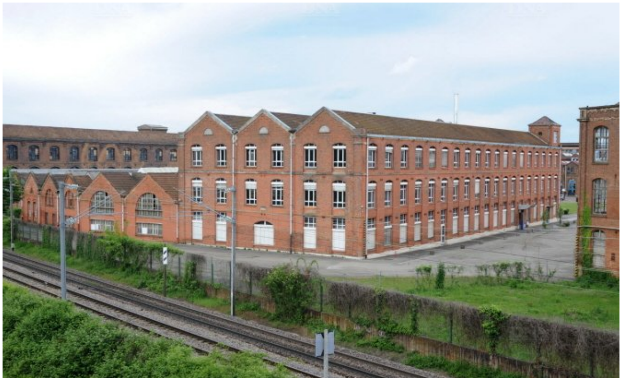
Le bâtiment 23 de la friche SACM appelé à accueillir le projet « KM0 », qui sera un des deux lieux « totem » du projet French Tech alsacien. photo Cathy KOHLER
